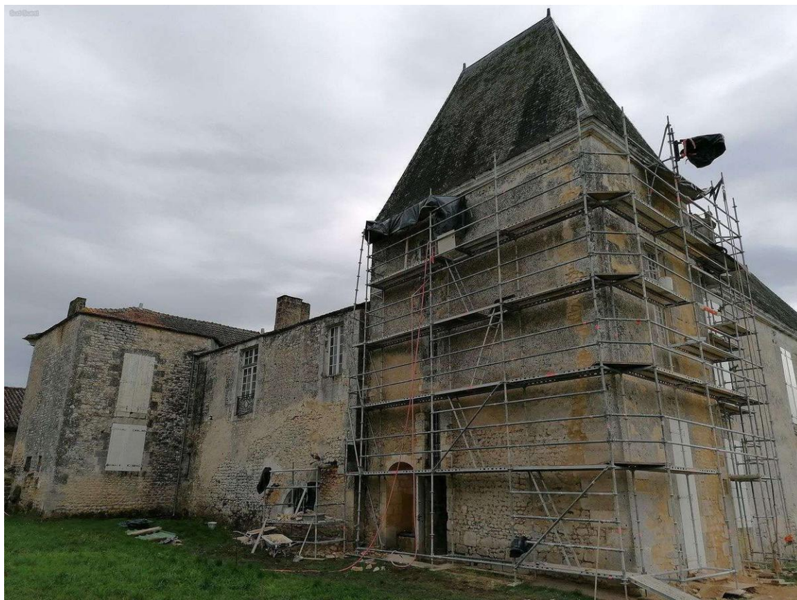
Les travaux sur la façade ouest ont débuté en janvier Crédit photo : h. r.
